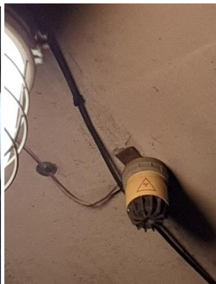
21., 22.attēli. Am-241 saturoši dūmu detektori RID-1 (РІД-1). Gamma dozas jaudas līmenis uz virsmas konstatēts līdz 10,6 \mu Sv/h, identificēts radionuklīds Am-241. Virsmas nosmērētība netika konstatēta.
