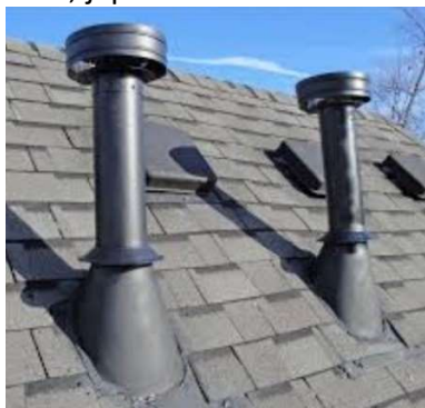
Ventilācijas izvads/ dūmenis ar šķērslī
